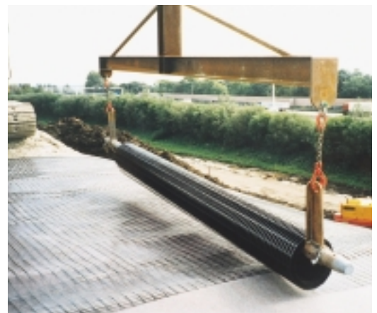
Secugrid® wird mit Hilfe einer Traverse verlegt.
