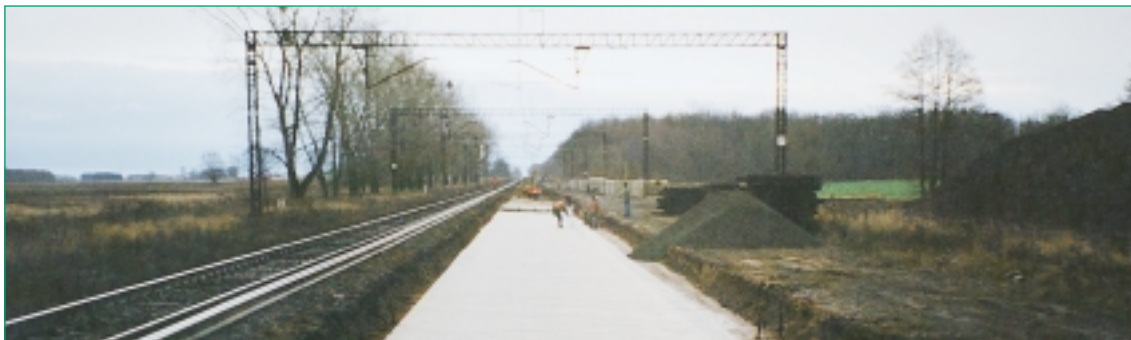
Bautrasse mit verlegtem Secugrid®-Geogitter und Secutex®-Vliesstoff
