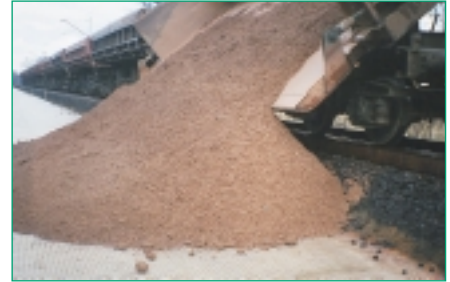
Beschüttung des verlegten Secugrid®-Geogitters
