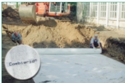
Verlegung von Combigrid® auf dem Busbahnhof in Melle, Wellingholzhausen.
