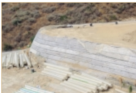
Bau einer Stützwandkonstruktion mit Secugrid®
