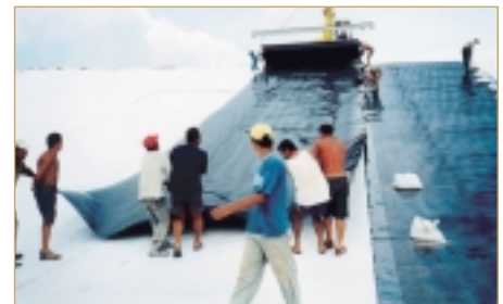
Verlegung von Carbofol® über Bentofix® als Kombidichtung
