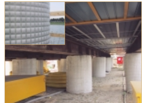
Geobarrier® als Aufständigung zum Hochwasserschutz
