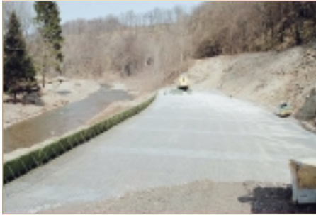
Einbau des Schüttmaterials auf Secugrid®
