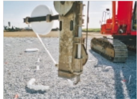
Bagger beim Einpressen von Secudrän® V durch die Tragschicht
