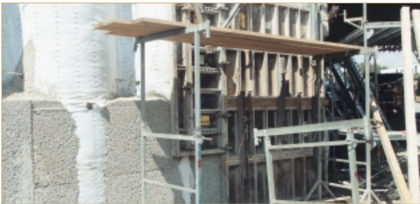
Einkornbeton als Ausgleichsschicht
