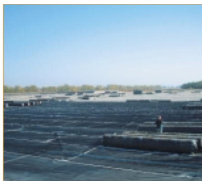
Geokunststoffverlegung auf der Deponie Miskolc, Ungarn
