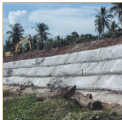
Böschungssicherung mit Secugrid® Geogittern.
