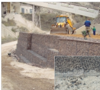
Frontansicht der Secugrid® bewehrten Rampenauffahrt
