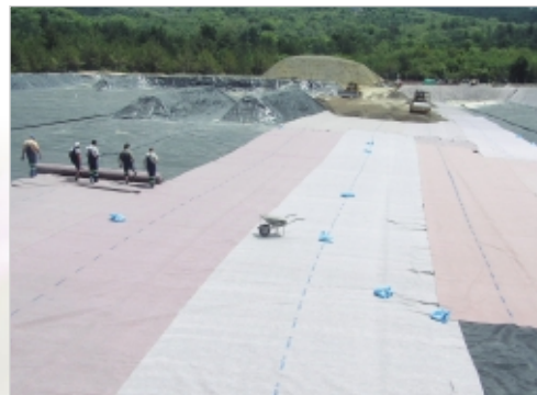
Secutex® Verlegung auf der Dichtung mit Carbofol® sowie Einbringung der mineralischen Dränschicht
