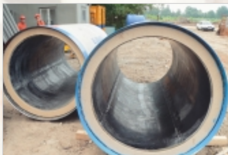
Fertige Rohrteile mit der Carbofix®-Abdichtung vor Verlegung
