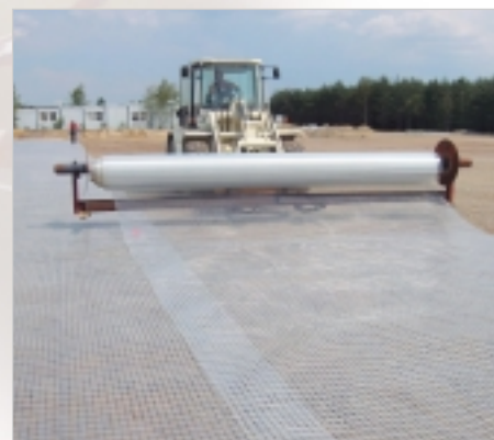
Secugrid®-Verlegung
