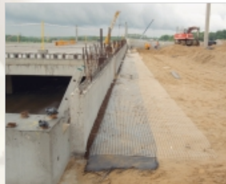
Secugrid®-bewehrter „Erddruckfänger“ vor Kellerwand
