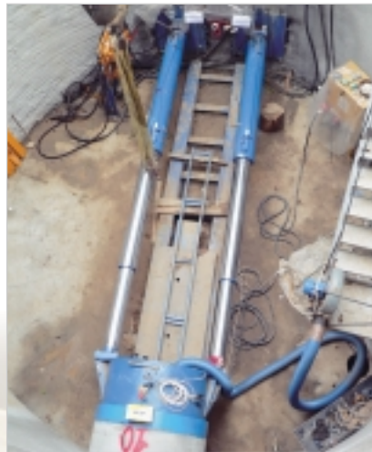
Vorschub eines Carbofix® gedichteten Rohres
