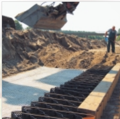
Beschüttung der Secugrid®-rückverankerten Geozellen
