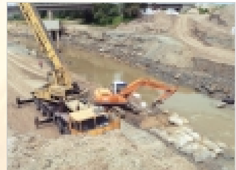
Einbau von Secutex® Sandcontainern als Damm für die Sedimentation von Feststoffen.
