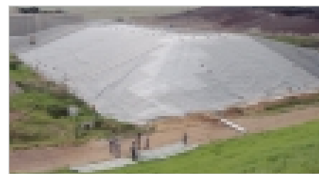
Die 1,5 mm starke verlegte Carbofol® PEHD-Dichtungsbahn.
