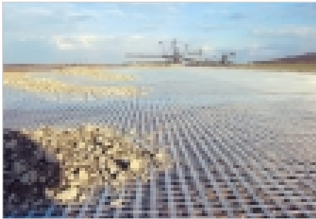
Secugrid® 100/100 Q6 vor der Überschüttung mit einem ehemaligen Abraumbagger im Hintergrund.
