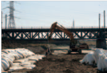
Positionierung des sandgefüllten Secutex® Sandcontainers zum Schutz des Flussbettes
