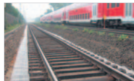
Verlegtes Secugrid® Geogitter unterhalb der Holzschwellen und PSS
