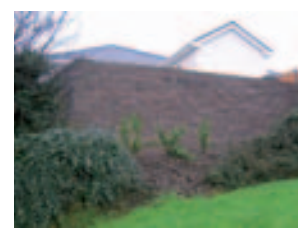
Secugrid® bewehrte Stützkonstruktion mit „International OMEGA“ Außenhautsystem, Irland
