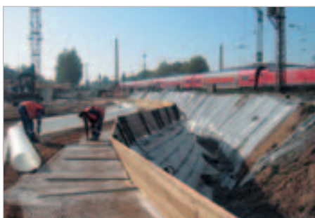
Secugrid® Geogitter Verlegung in der Dammböschung
