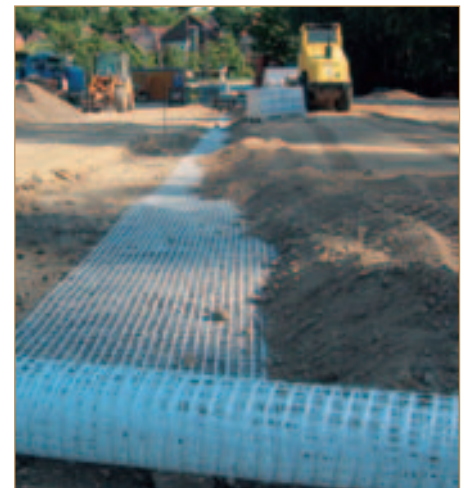
Secugrid® zur Lastverteilung unter Recyclingmaterial
