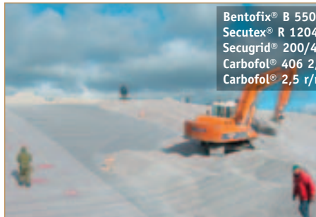
Böschungssicherung mit NAUE Geokunststoffen
