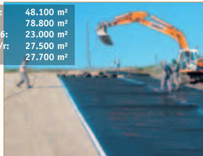
Verlegung von Carbofol® Kunststoffdichtungsbahnen
