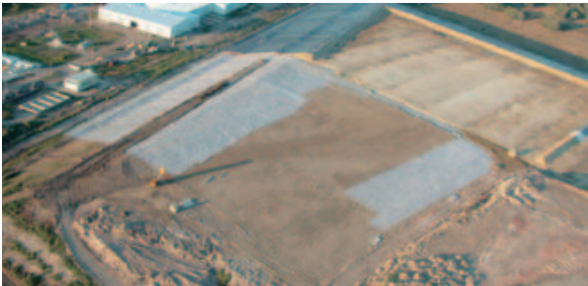
Luftaufnahme der Deponie Szeged während der Geokunststoffverlegung
