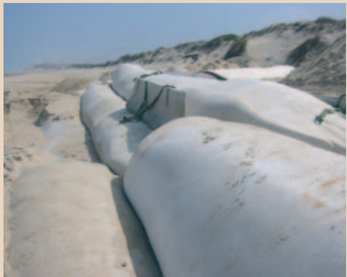
Terrafix® Soft Rock Verlegung für den Küstenschutz an der portugiesischen Küste
