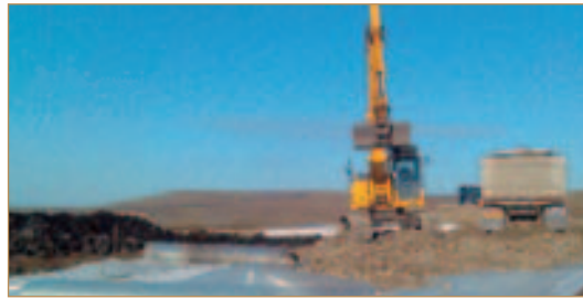
Beschüttung der verlegten Secugrid® Geogitter Tragschichtbewehrung
