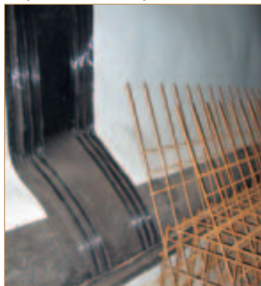
Carbofol® Fugenband fest auf Carbofol® Tunnelbahn verschweißt
